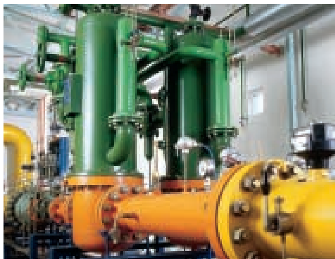
Échangeur de chaleur pour le préchauffage du gaz naturel avant son entrée dans la turbine de détente
