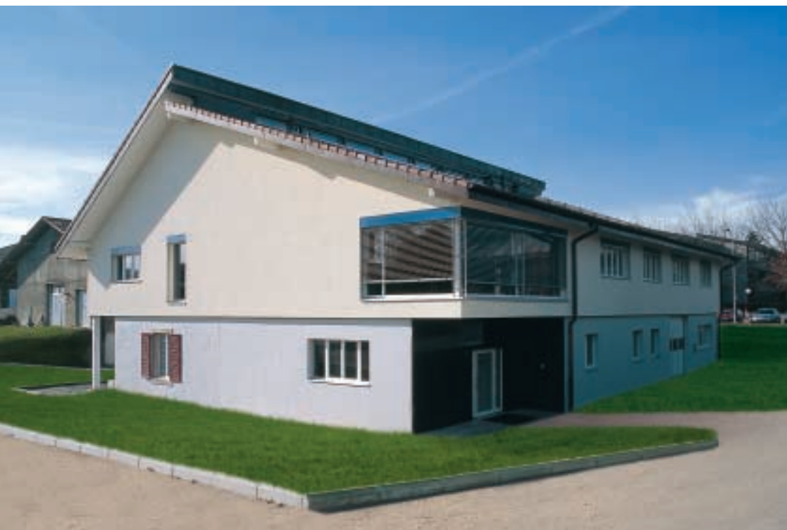
Le nouveau bâtiment de la société Cosvegaz SA, à Cossonay
